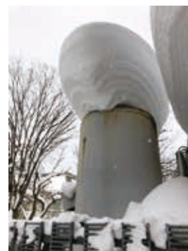
液体窒素貯蔵タンク上の雪 (令和4年2月7日)
